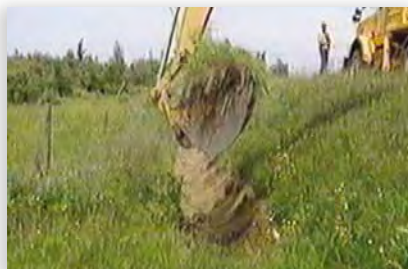
Excavation du fond du fossé à partir du talus opposé à la route, jusqu'à l'entaille.
